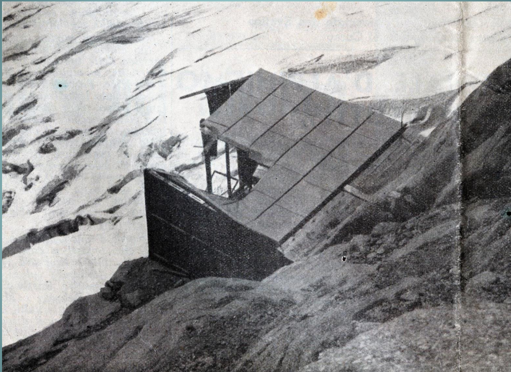
Nella primavera del '57 una grossa caduta di seracchi o un grosso masso danneggiava la parte posteriore del tetto. (da Monti e Valli anno XII n.3 Luglio-Settembre 1957)
