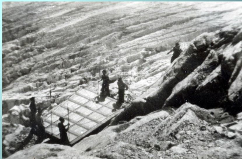
Preparazione della piazzola e posa del basamento
